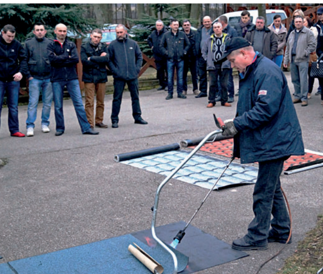
Wykonawcy z uwagą przyglądali się pracom wykonywanym przez instruktora. Ta część szkolenia najbardziej zapadła im w pamięć.
